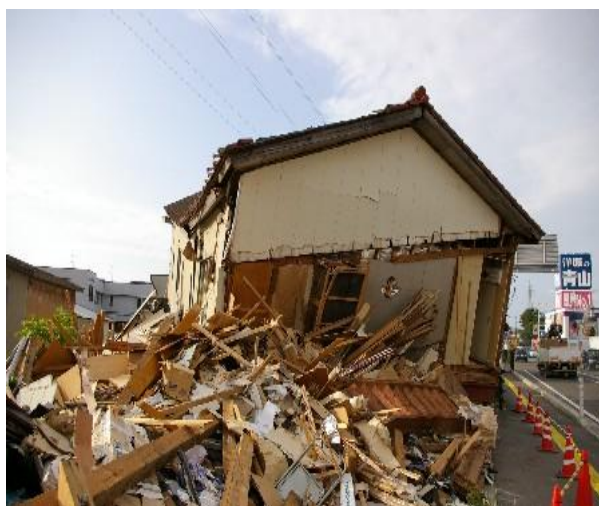
図 4.3.2 震災で倒壊した家屋
